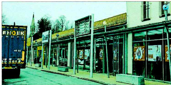
Die Umbauarbeiten laufen bereits: Am 22. März soll die „Fussl Modestraße“ in den ehemaligen Vögele-Räumen im Arberzentrum eröffnet werden.
